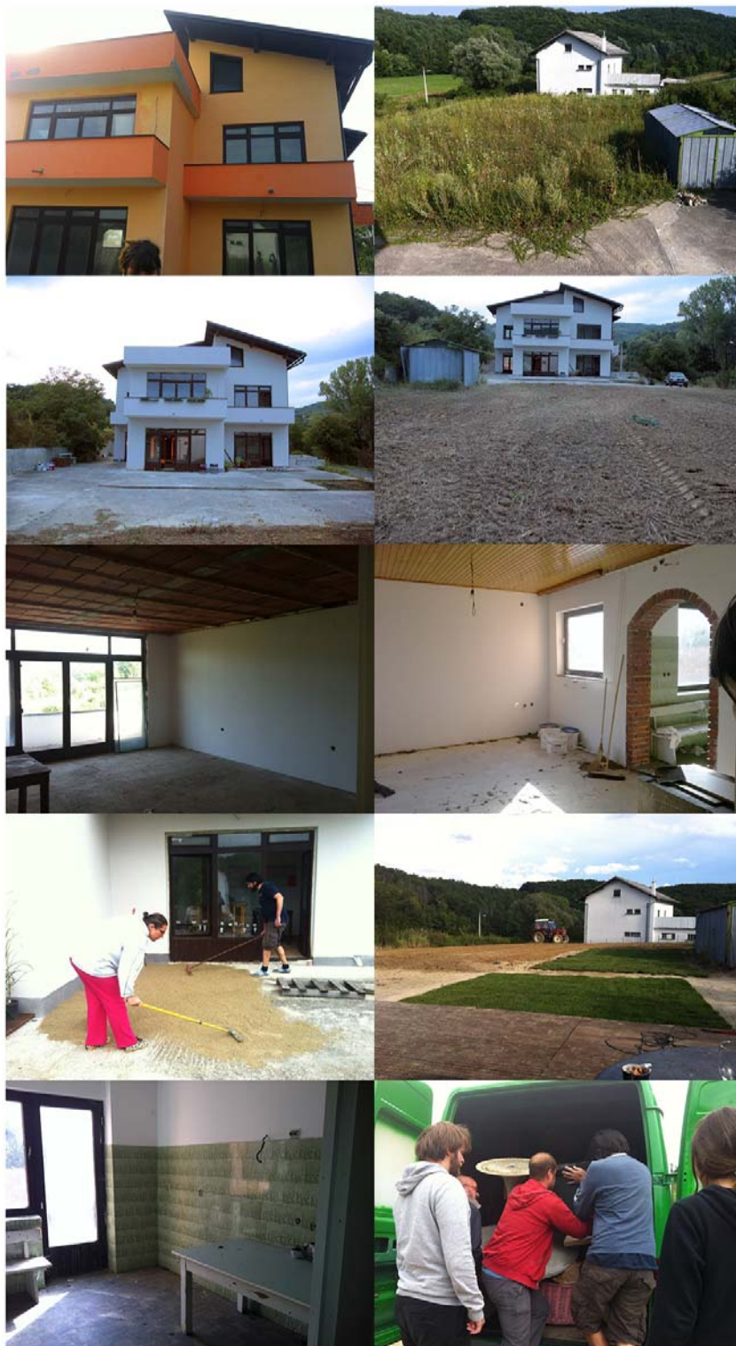
Slika 5. Radovi na kući
