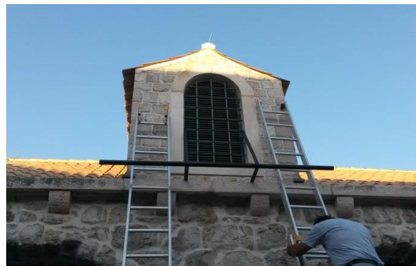
Slika 68: montaža improvizirane rasvjetne konstrukcije
