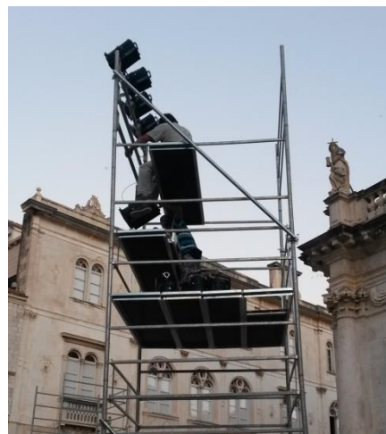
Slika 61: montažni rasvjetni toranj od aluminijskih elemenata
