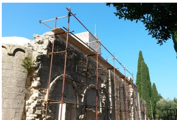
Slika 66: pogled na stražnji dio zida
