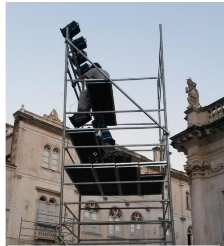
Slika 61: montažni rasvjetni toranj od aluminijskih elemenata
