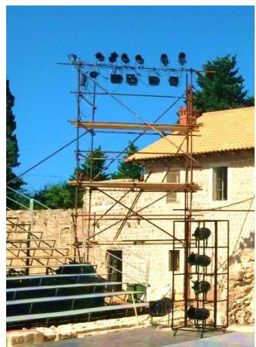
Slika 60: rasvjetni toranj izrađen od građevinske cijevi i drvenih daski
