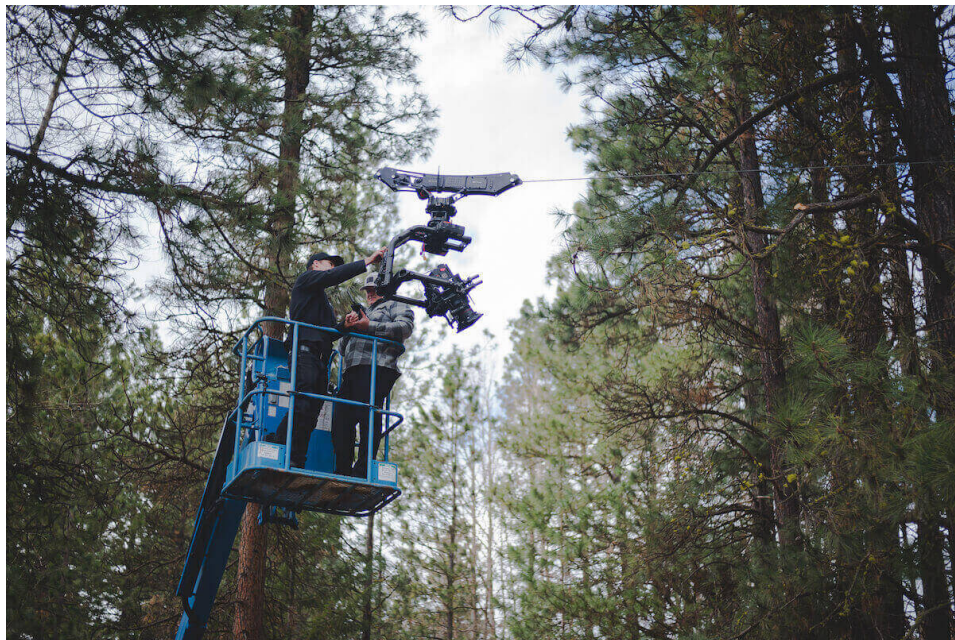
Slika 13 – Postavljanje Cablecam-a s fiksnim kablom
