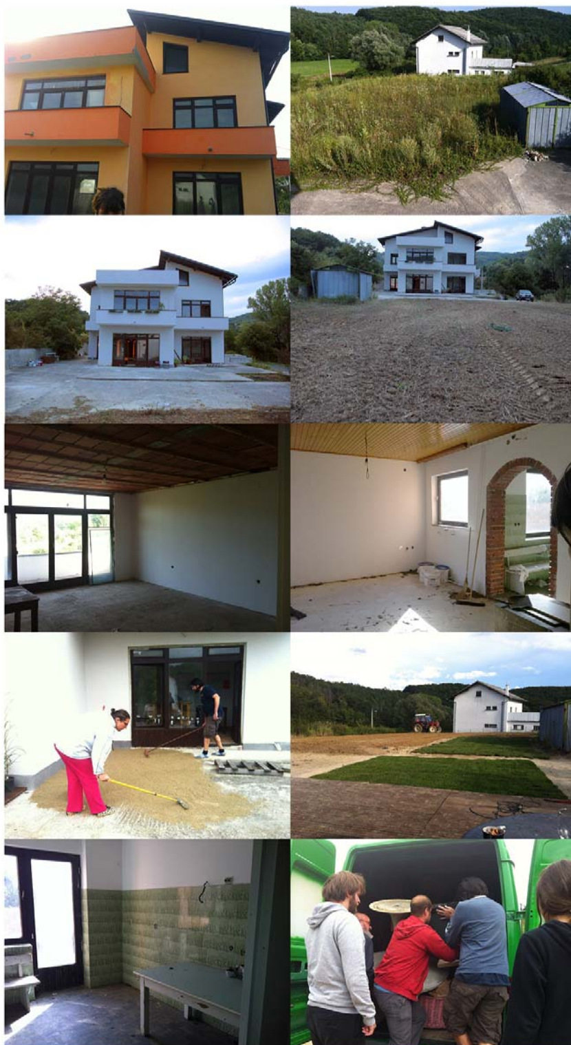
Slika 5. Radovi na kući
