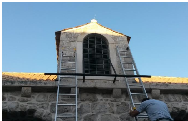
Slika 68: montaža improvizirane rasvjetne konstrukcije
