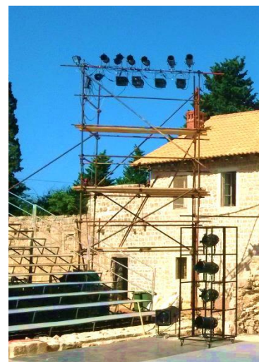
Slika 60: rasvjetni toranj izrađen od građevinske ih cijevi i drvenih daski
