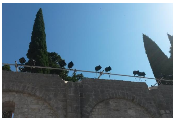
Slika 67: pogled na prednji dio zida
