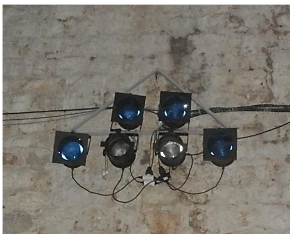
Slika 69: improvizirano vješalo s već montiranim reflektorima
